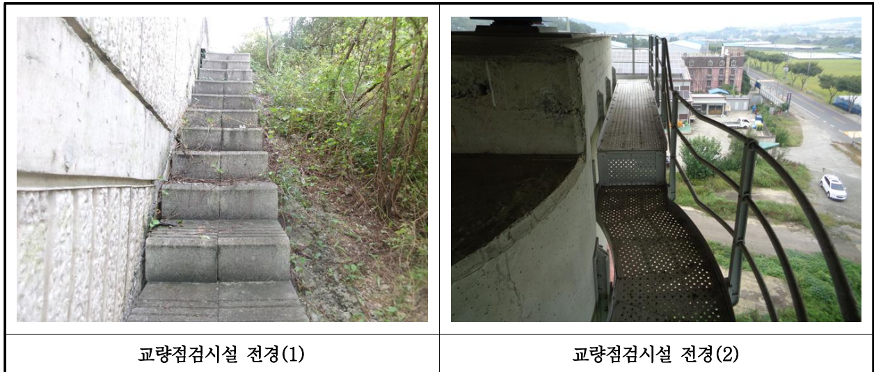
【사진 41.3.25】 교량 점검시설 전경
