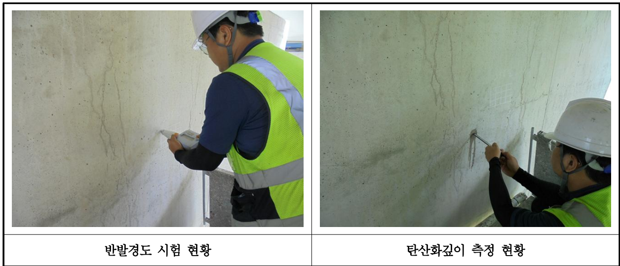
【사진 41.4.1】 콘크리트 내구성조사 현황
