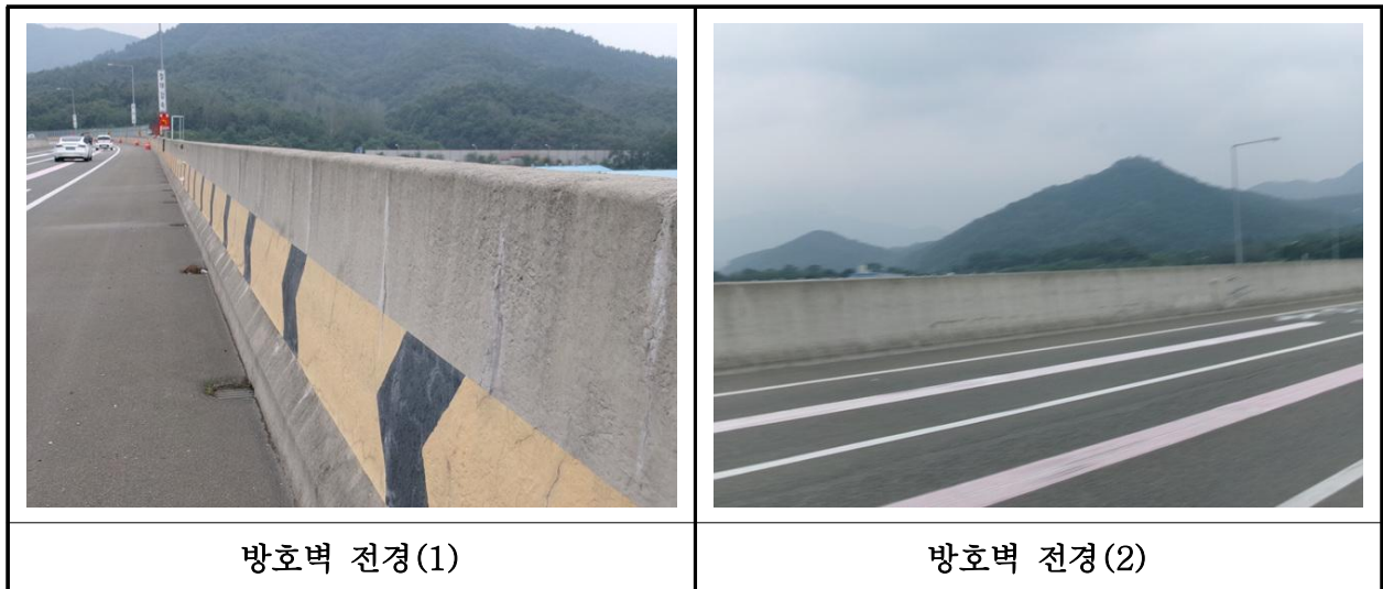
【사진 41.3.23】 방호벽 및 중앙분리대 전경
