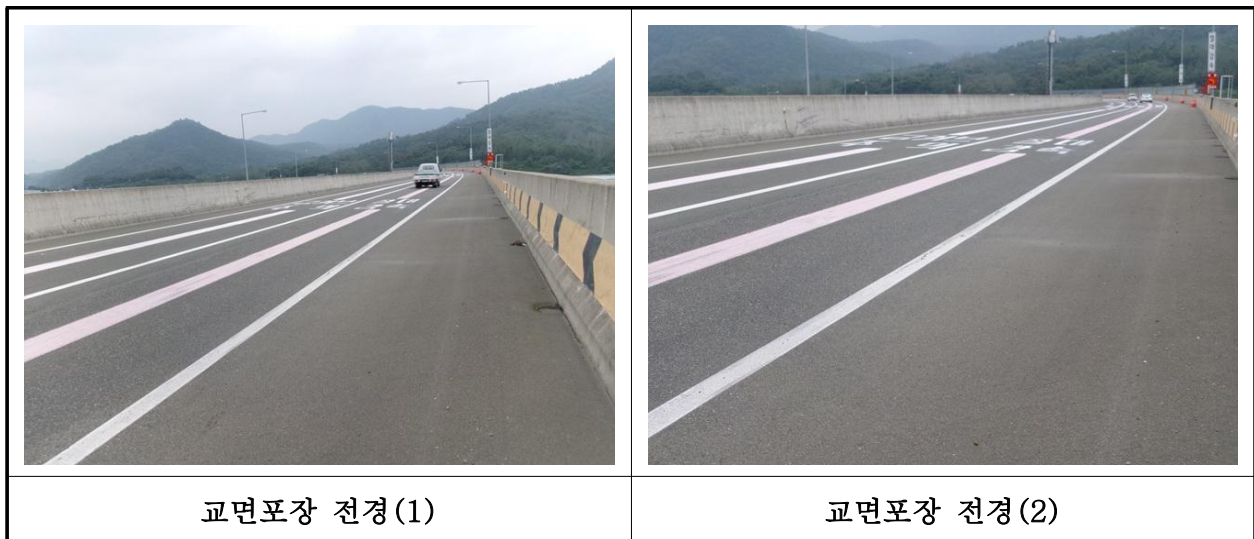
【사진 41.3.19】 교면포장 전경
