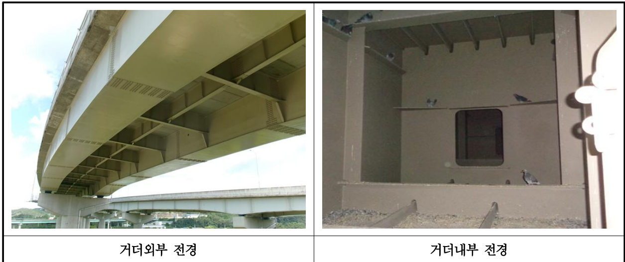
【사진 41.3.4】 거더 내·외부 전경
